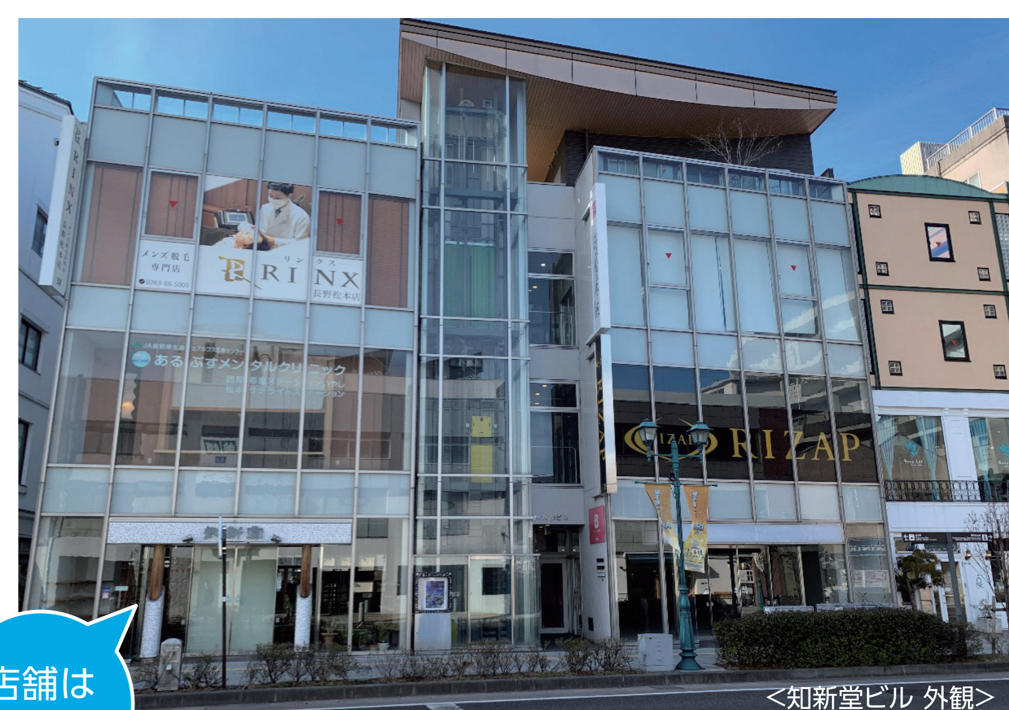
<知新堂ビル 外観>
